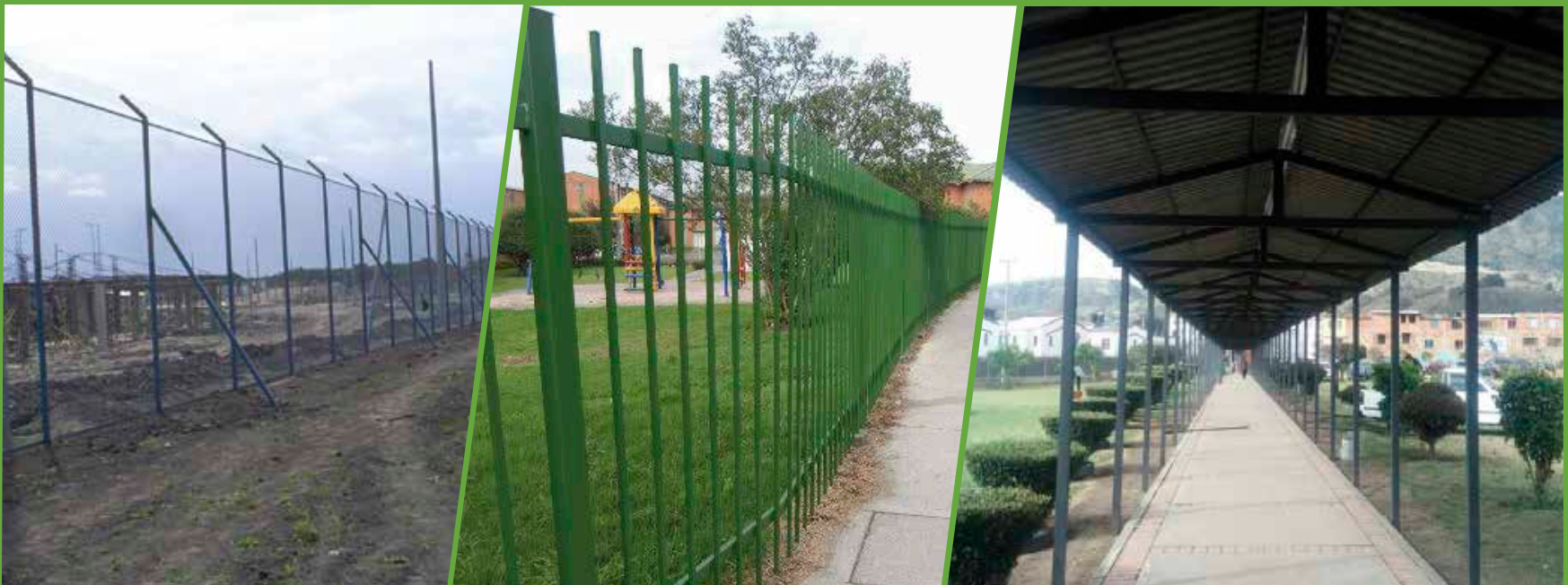
Fabricación, montaje y mantenimiento de cerramientos y cubiertas
