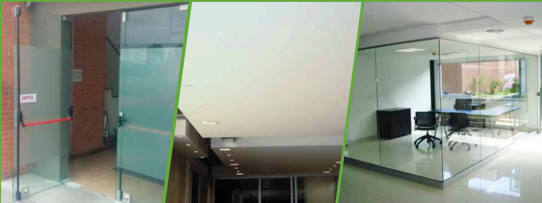
Adecuaciones, reparaciones y mantenimientos locativos en vidrio, drywall y acabados arquitectonicos
