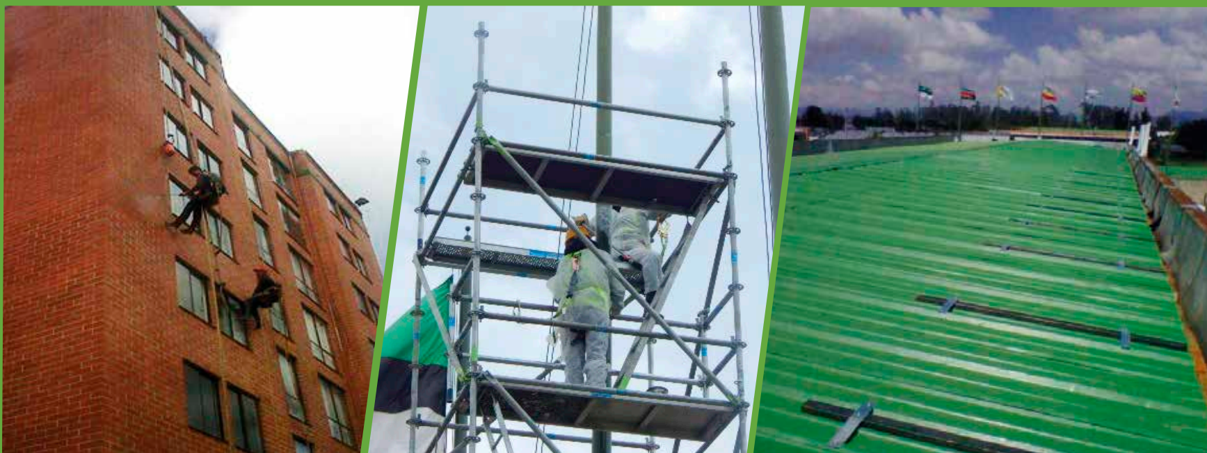
Mantenimiento y limpieza de fachadas
